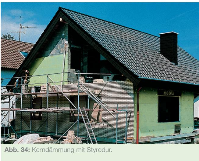
Abb. 34: Kerndämmung mit Styrodur.
