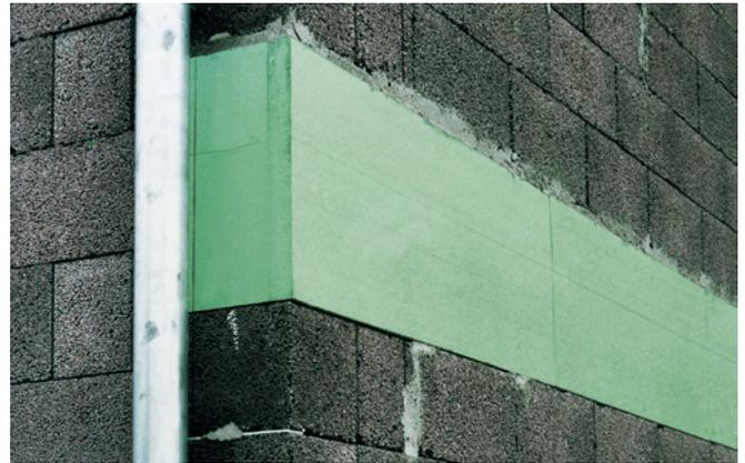
**Abb. 2:** Wärmedämmung am Deckenrand mit Styrodur 2800 C/Q.
