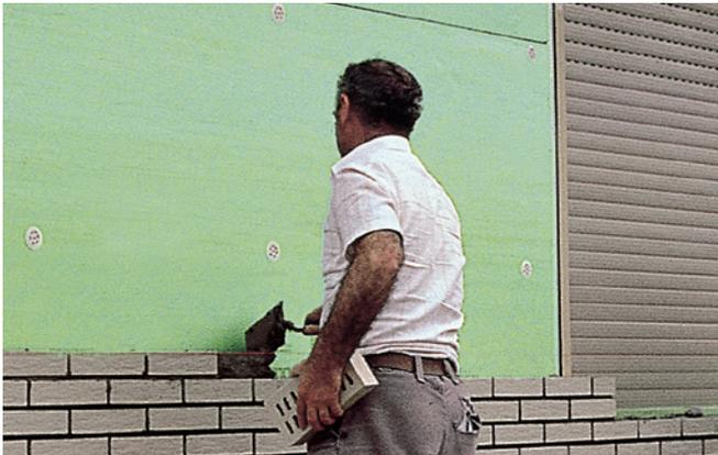
Abb. 33: Kerndämmung mit 9 cm breiten Vormauerziegeln.
