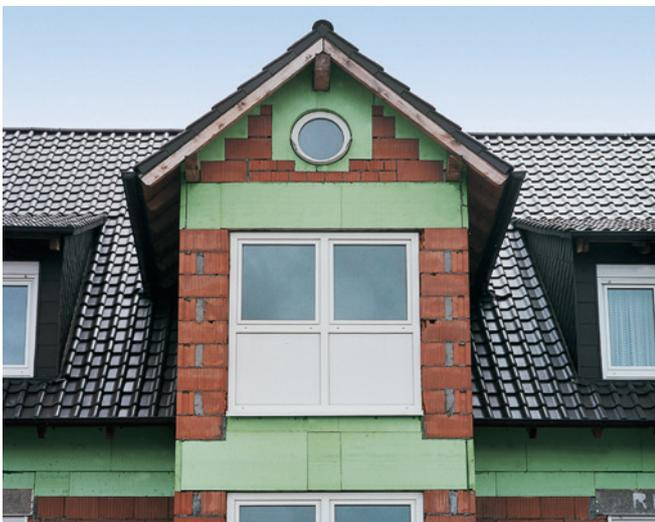
**Abb. 1:** Wärmebrückendämmung von Betonbauteilen:
