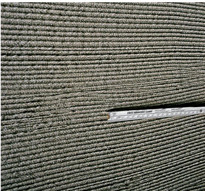
Abb. 24: Horizontal gekämmte Haftbrücke auf Styrodur-Dämmung.
