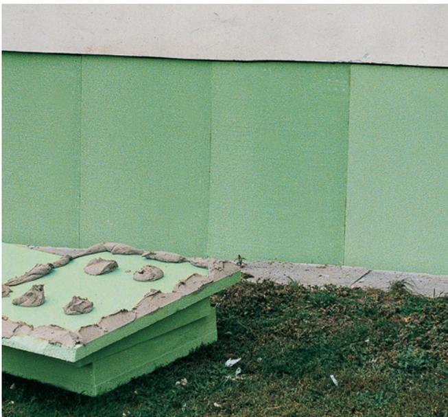
**Abb. 31:** Altbausanierung; Ankleben von Styrodur 2800 C/Q-Platten im Wulst-Punkt-Verfahren.
